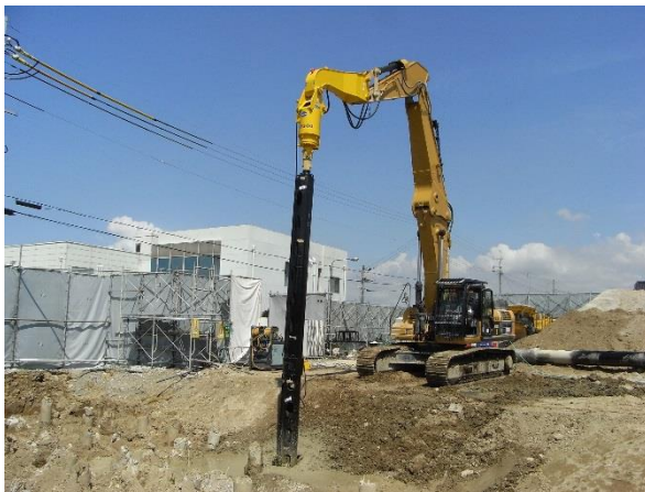
CAT 336D オーガ AG5300 ケーシング \phi 508 \times 6\text{m}
