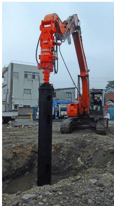
住友建機 SH200 オーガ AG5300 ケーシング \phi 508 \times 6\text{m}
