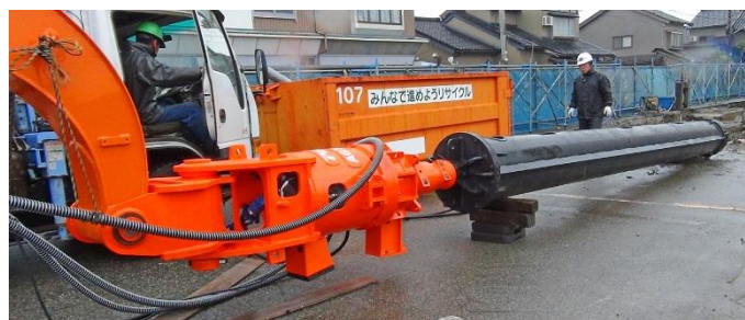
住友建機 SH200 オーガ AG5300 ケーシング \phi 508 \times 6\text{m}
