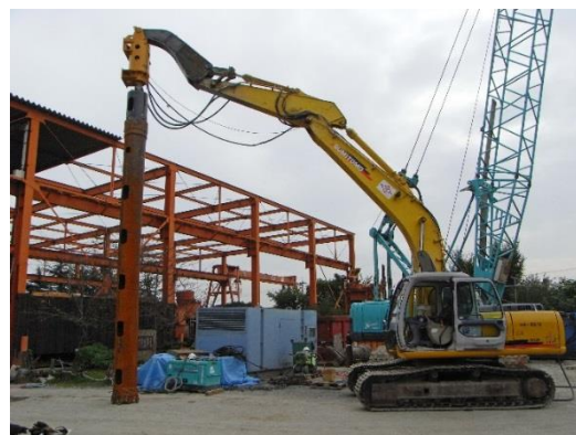
住友建機 SH200 オーガ AG5300 ケーシング \phi 508 \times 6\text{m}
