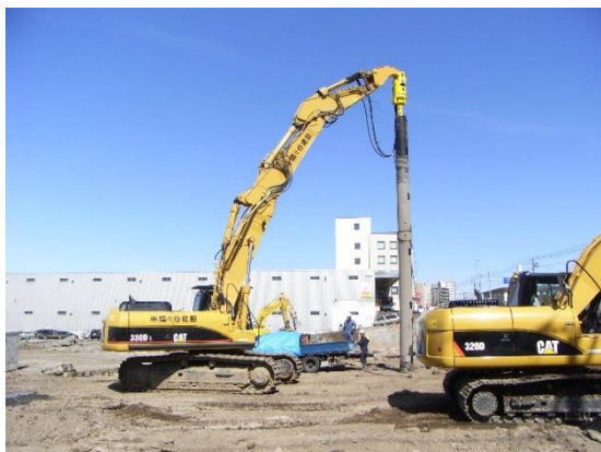
CAT 330D オーガ AG4000 ケーシング \phi 508 \times 10\text{m}
