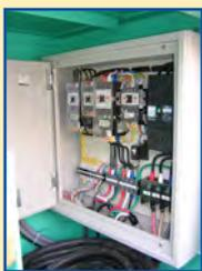
配電盤には、感電事故を防ぐ為漏電遮断機を装備、及びモータの過負荷保護を行う熱動形過負荷継電器（サーマルリレー）を装備しています。また、電磁開閉器によりモータの始動停止を行っているので停電等によりモータが停止した時、電源が復活してもいきなり始動しないので安全です。
